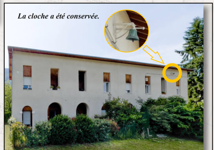
Le bâtiment de l'école a été transformé en logement sociaux.
