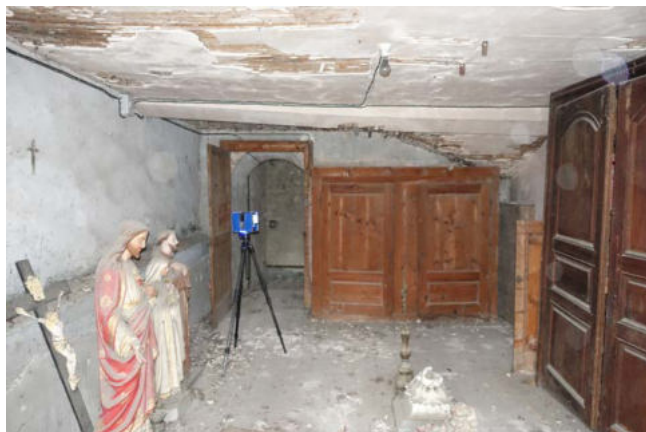
Étage du chœur - mur Sud séparatif avec clocher
