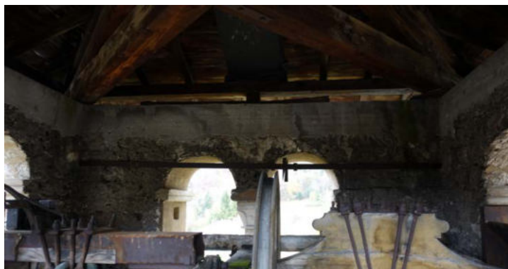
Clocher, mur Sud - Tirant métallique, chaînage béton
