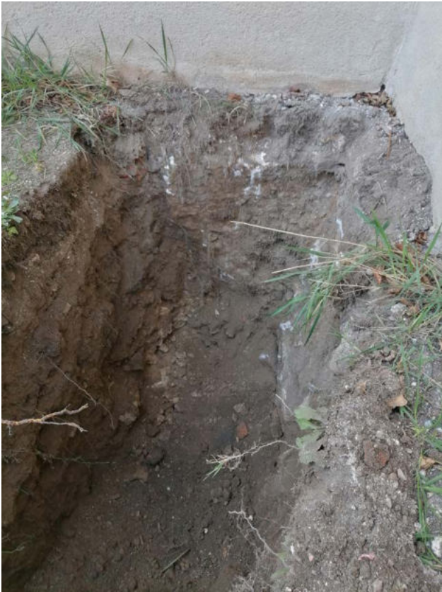
Sondage 3 : angle clocher/chœur Fondation ancrée dans le bon sol
