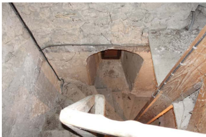
Clocher, mur Est - Enduit avec fresque au rdc, puis pierre apparente
