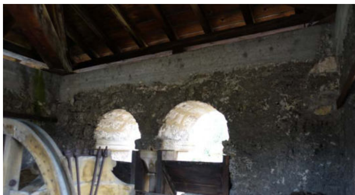
Clocher, mur Ouest - Chaînage béton, abat-sons
