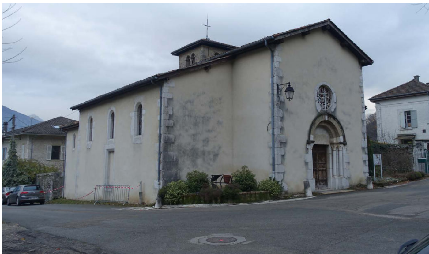
Façades Nord et Ouest
