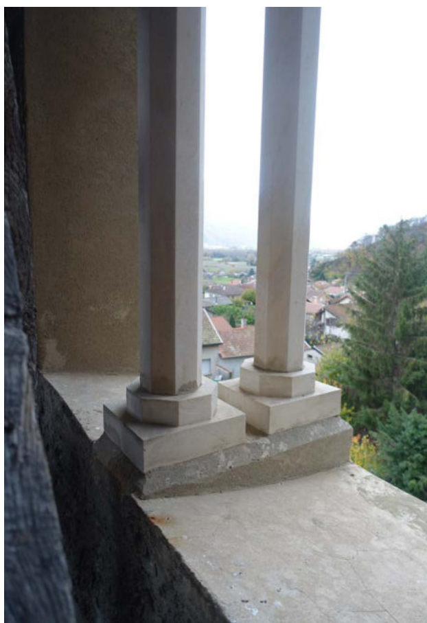
Clocher, mur Sud - 8 colonnes déposées et remplacées pour conservation
