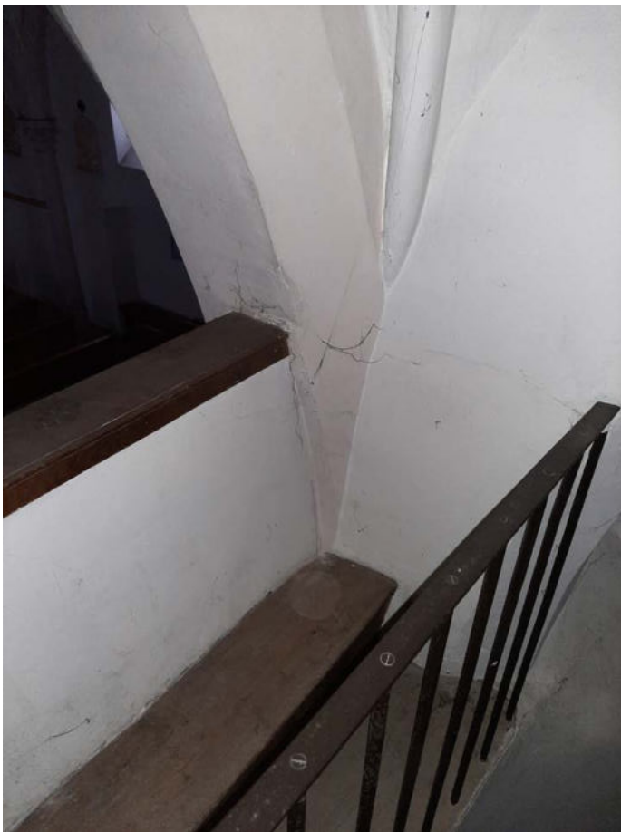
Garde-corps tribune - Fissuré de part et d'autre, instable
