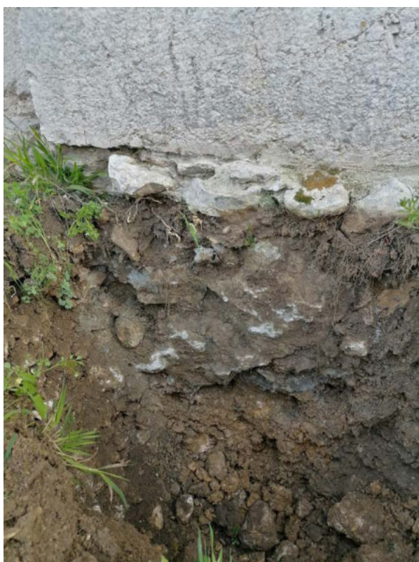
Sondage 4 : bas-côté nord Fondation ancrée dans le bon sol
