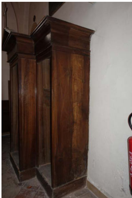
Confessionnal - attaque humide et parasitaire en cours, à traiter
