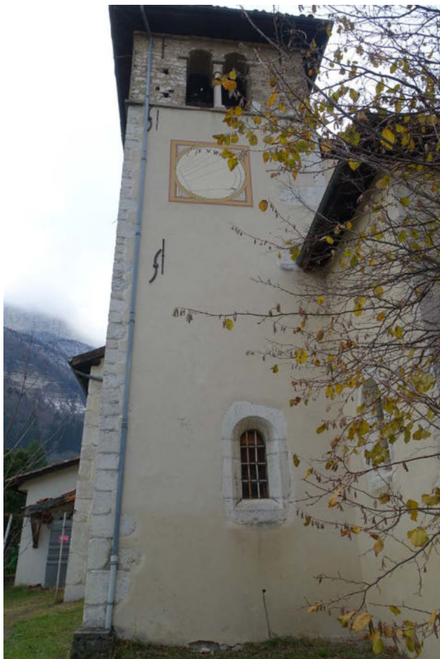
Façade Nord - clocher
