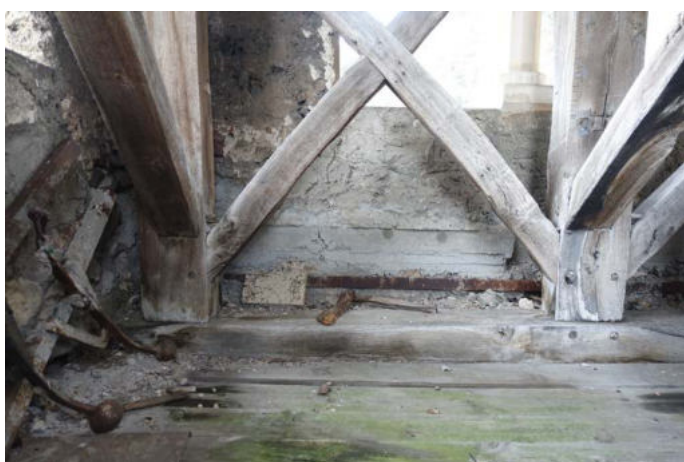
Charpente beffroi - Sud
