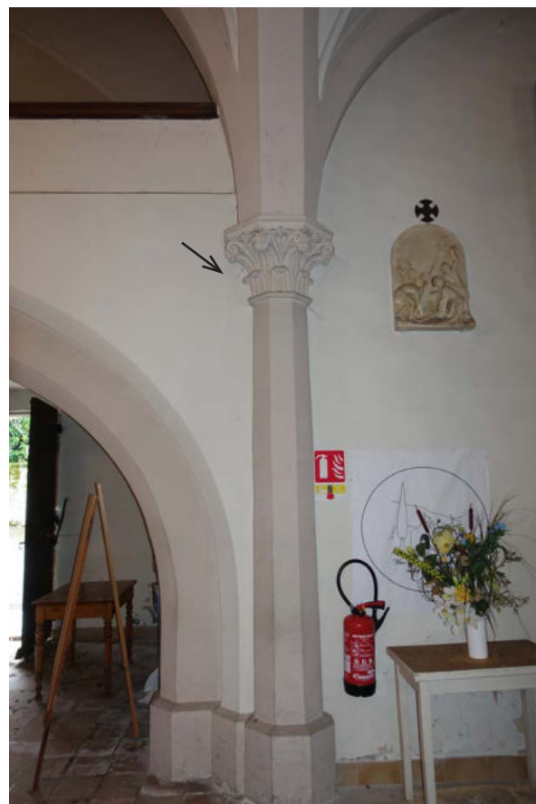
Fissures de part et d'autre de la tribune
