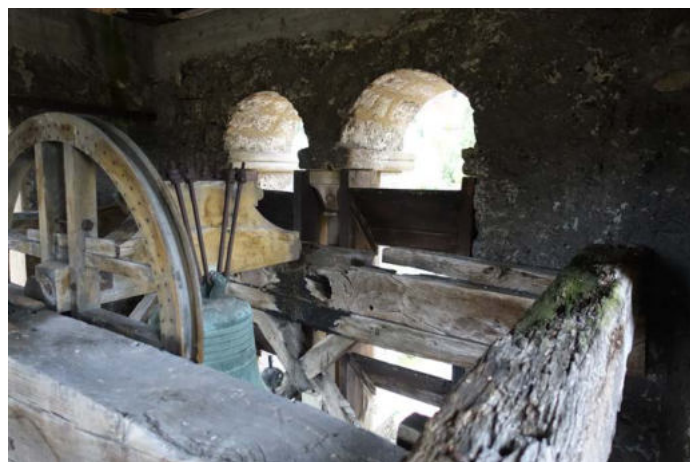
Charpente beffroi - Nord et Ouest
