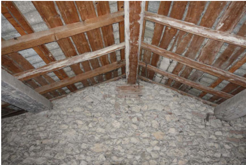
Charpente porche d'entrée
