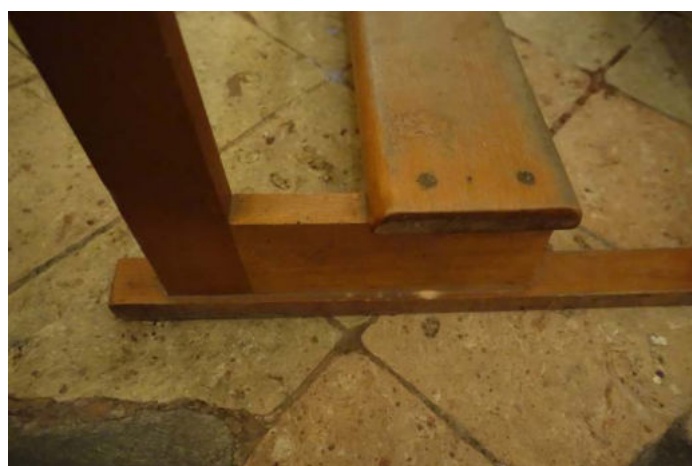
Bancs de la nef - attaque parasitaire en cours à traiter
