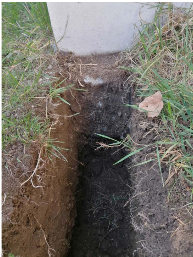
Sondage 1 : chaufferie Pas de fondations visibles Chaufferie posée sur dalle
