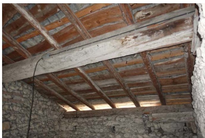
Panne intermédiaire pan Nord porche d'entrée
