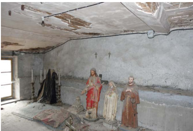
Étage du chœur, mur Est - Enduit ciment, surélévation ? chaînage béton ?
