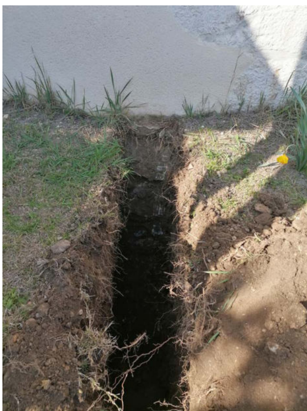
Sondage 2 : bas-côté sud (ancienne chapelle) Fondation ancrée dans le bon sol
