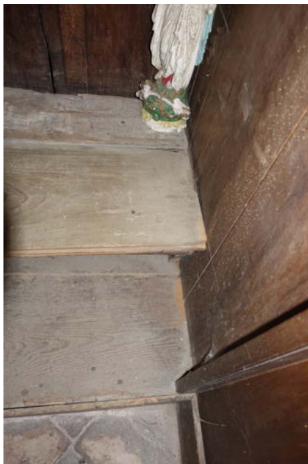
Confessionnal - attaque humide et parasitaire en cours, à traiter
