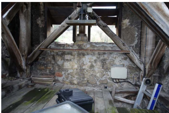
Charpente beffroi - Ouest
