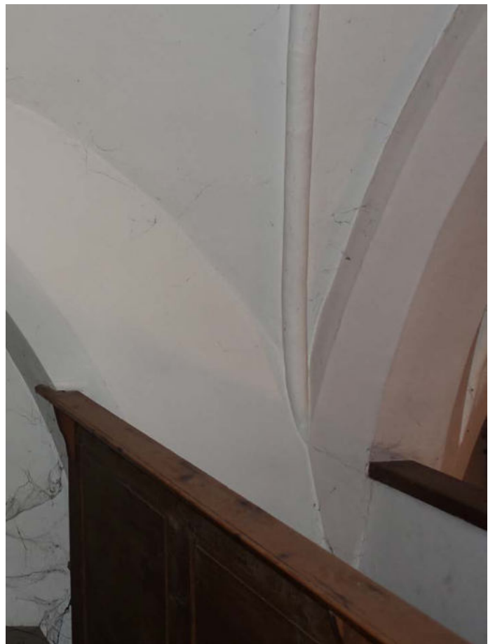
Garde-corps tribune - Fissuré de part et d'autre, instable
