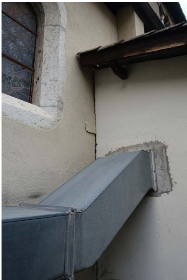
Façade Sud - arrachement de la chaufferie et du conduit
