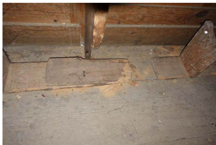
Bancs de la tribune- attaque parasitaire en cours à traiter
