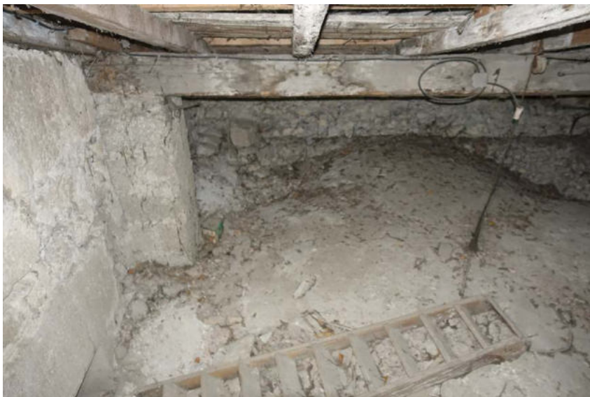
Bas-côté Sud - Appuis de la panne intermédiaire au niveau du mur Est
