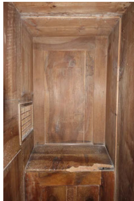
Confessionnal - attaque humide et parasitaire en cours, à traiter
