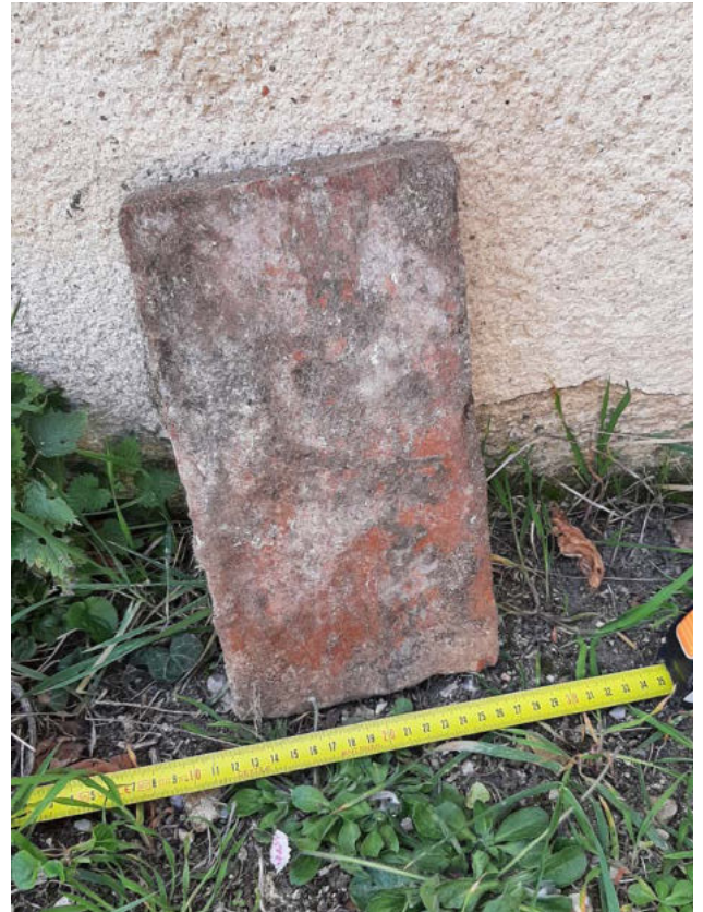
Sondage 3 : angle clocher/chœur Dalette de sol en terre cuite
