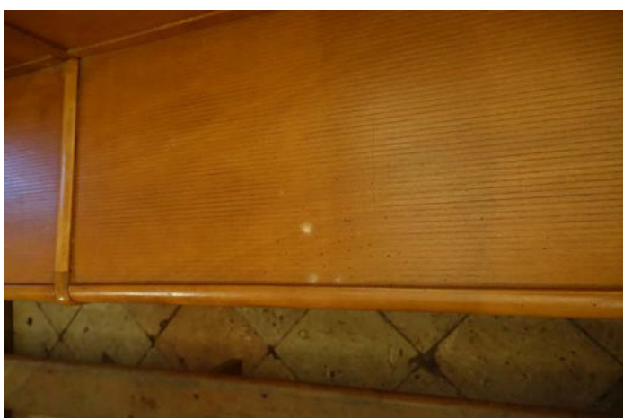
Bancs de la nef - attaque parasitaire en cours à traiter
