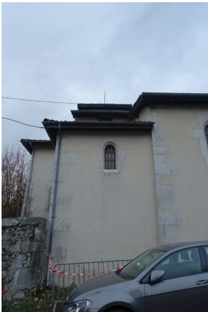
Façade Nord- sacristie
