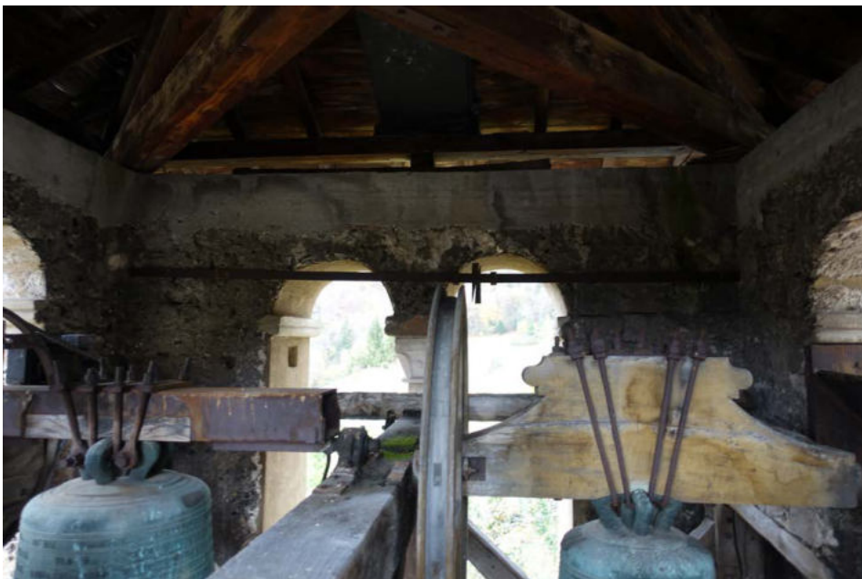
Charpente beffroi - moutons
