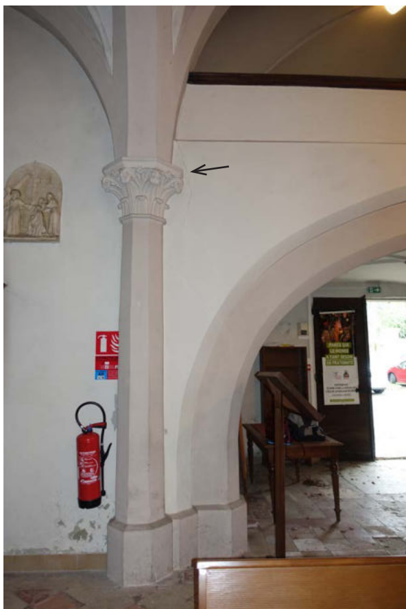
Fissures de part et d'autre de la tribune
