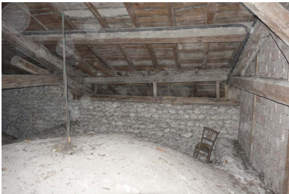
nef centrale travée Est pan Nord - double panne sur potelets bois
