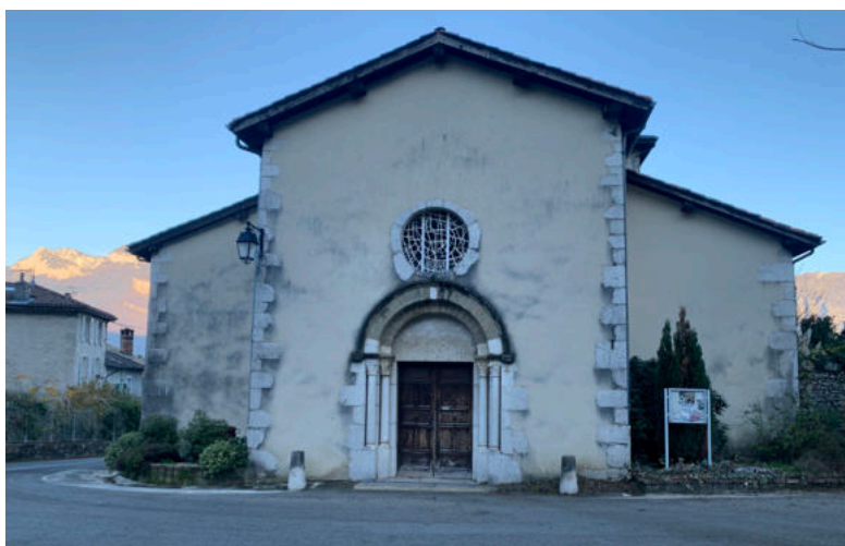
Les massifs maçonnés surélevés au pied de la façade
