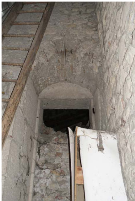
Clocher, mur Ouest, niveau intermédiaire - Ancienne ouverture bouchée
