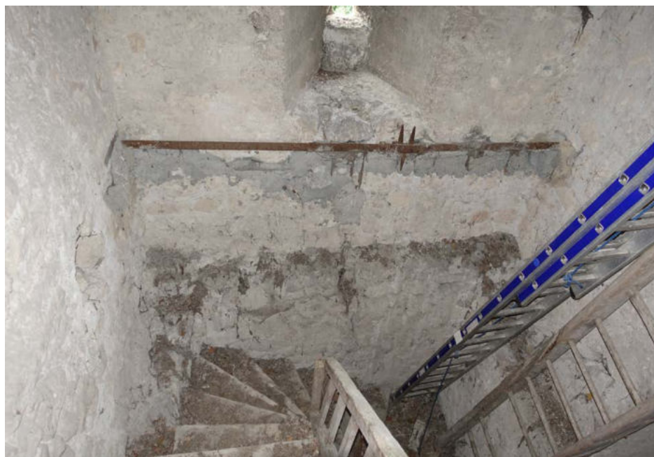
Clocher, mur Sud - 1 tirant métallique et 1 tirant encastré dans le mur
