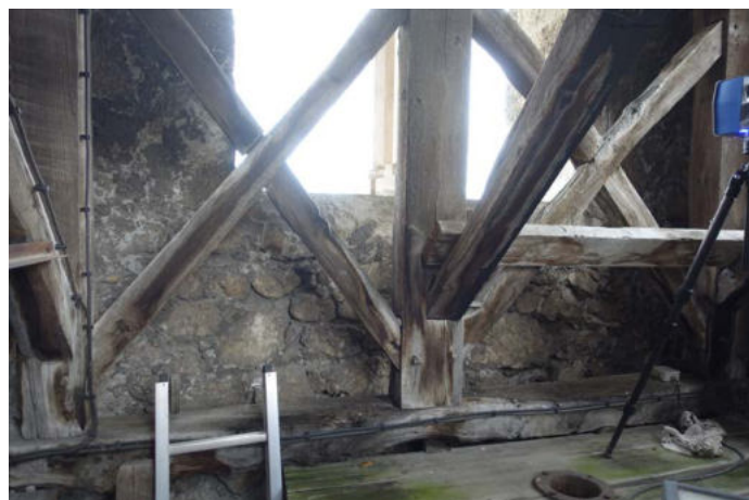
Charpente beffroi - Nord
