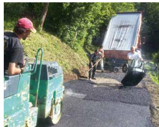
Enfin, des travaux d'émulsion seront réalisés par la société Blache du 15 au 21 juillet afin de réparer les nids de poules et autres détériorations de chaussées. ■
