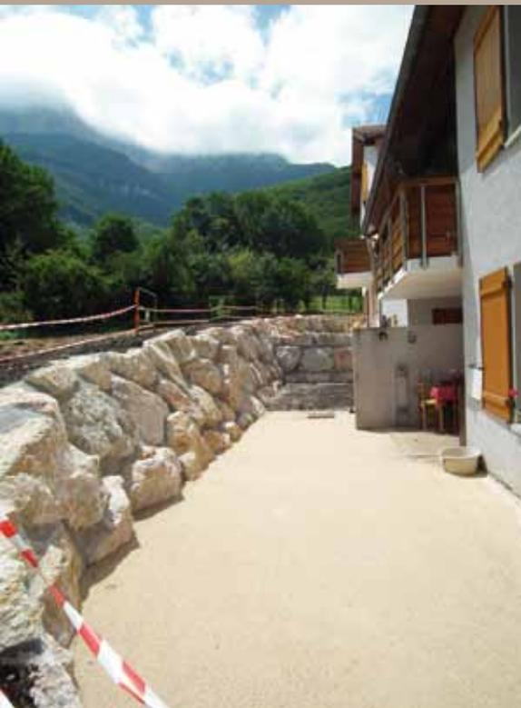
Ces travaux effectués par l'entreprise Toutenvert portent sur la mise à la côte des regards existants sur les espaces verts ; l'aménagement d'une plateforme et pose d'un grillage de sécurité au niveau du talus ; la réalisation de places de stationnement (bordures + enrobés) ; l'enrochement derrière le cabinet médical ; la reprise du caniveau central sur la voirie principale. Ils seront terminés mi-juillet.
